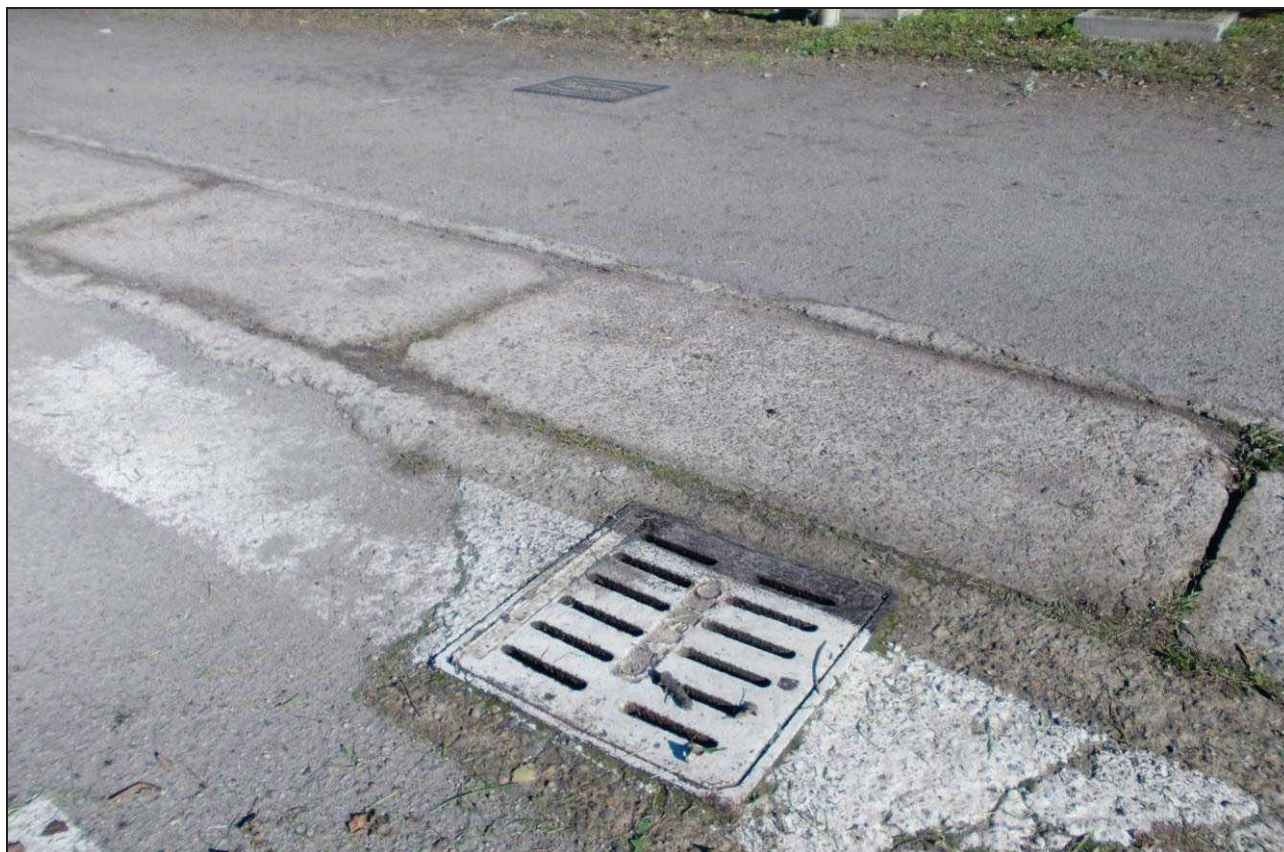
Figura 4.4: particolare delle caditoie nel settore sud occidentale servito della rete fognaria esistente
